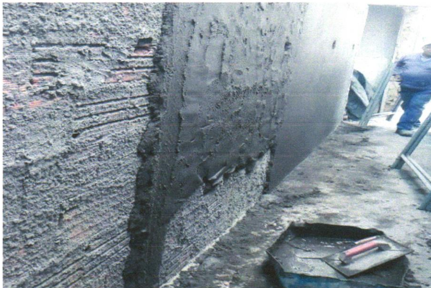
Foto 12 - MASSA ÚNICA, PARA RECEBIMENTO DE PINTURA OU CERÂMICA, ARGAMASSA INDUSTRIALIZADA, PREPARO MECÂNICO, APLICADO COM EQUIPAMENTO DE MISTURA E PROJEÇÃO DE 1,5 M3/H EM FACES INTERNAS DE PAREDES, ESPESSURA DE 5MM, SEM EXECUÇÃO DE TALISCAS. AF_06/2014
