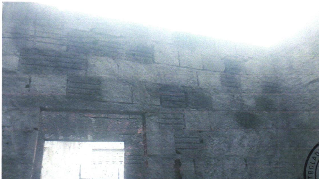
FOTO 09 – CHAPISCO APLICADO EM ALVENARIA (COM PRESENÇA DE VÃOS) E ESTRUTURAS DE CONCRETO DE FACHADA, COM EQUIPAMENTO DE PROJEÇÃO. ARGAMASSA TRAÇO 1:3 COM PREPARO EM BETONEIRA 400 L. AF_06/2014
